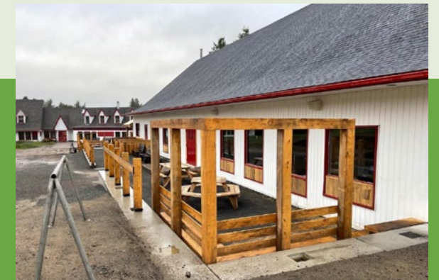
MONT SM | Aménagement d'une nouvelle terrasse
